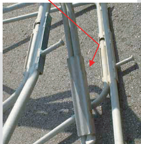
※供試体 No.8 [妻側] 取付ピンのはずれ
